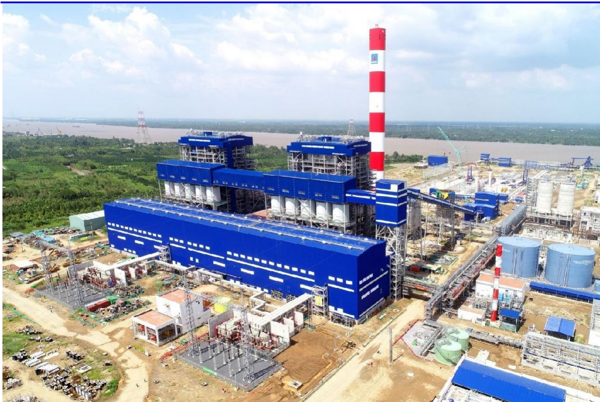
NHÀ MÁY NHIỆT ĐIỆN SÔNG HẬU 1
