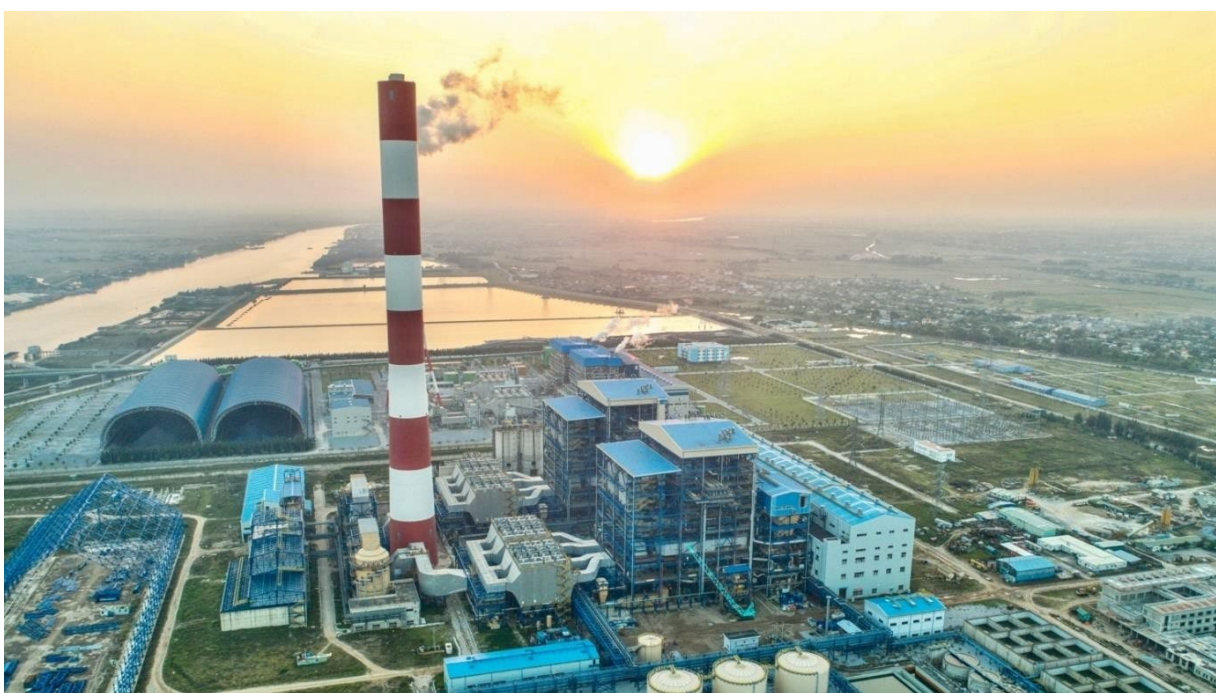
NHÀ MÁY NHIỆT ĐIỆN THÁI BÌNH 2
